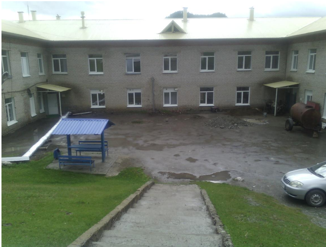
Фото№6 Путь (пути) движения на территории Пути эвакуации (вт.ч. зоны безопасности)
